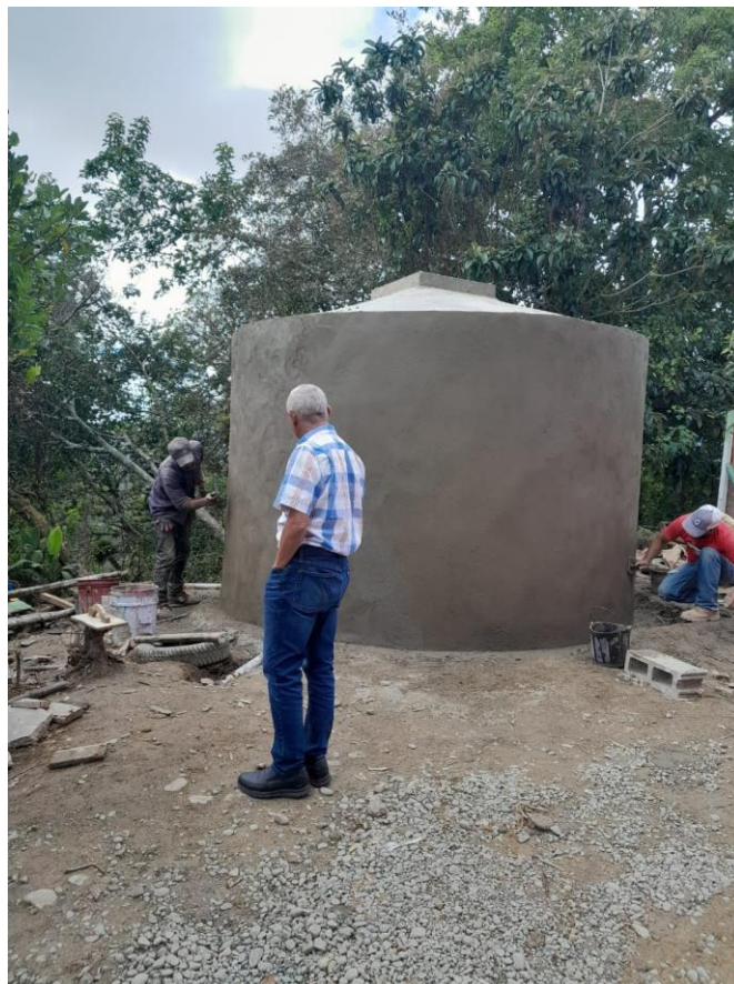
Construcción acueducto La Pita ( Obra en Ejecución)
