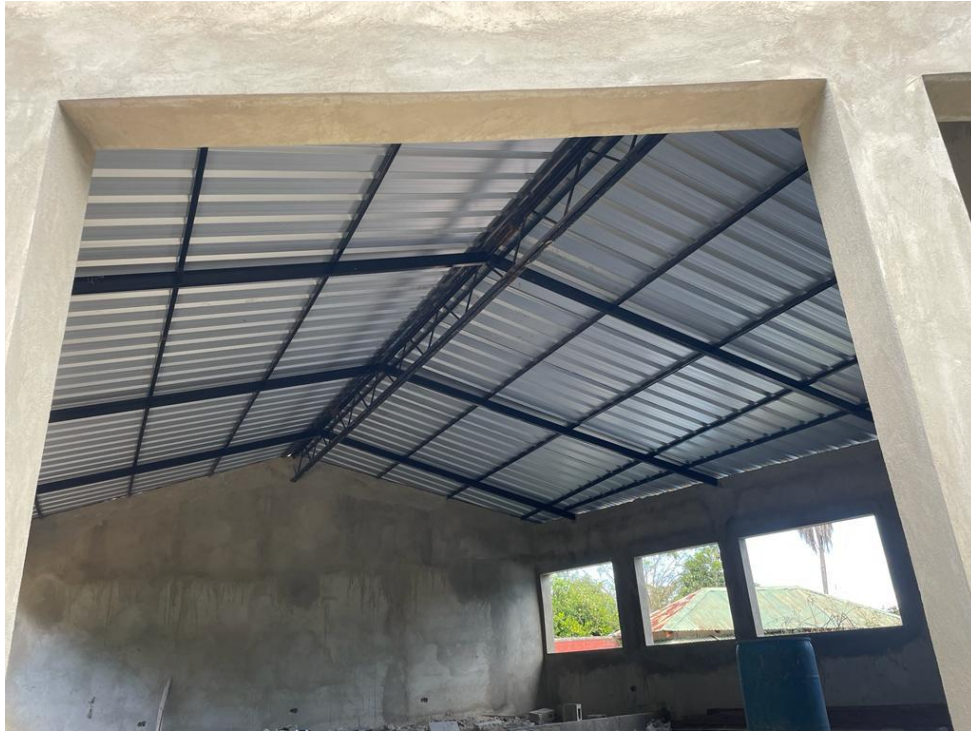
Salón Comunal en el sector Estancita (obra en ejecución).
