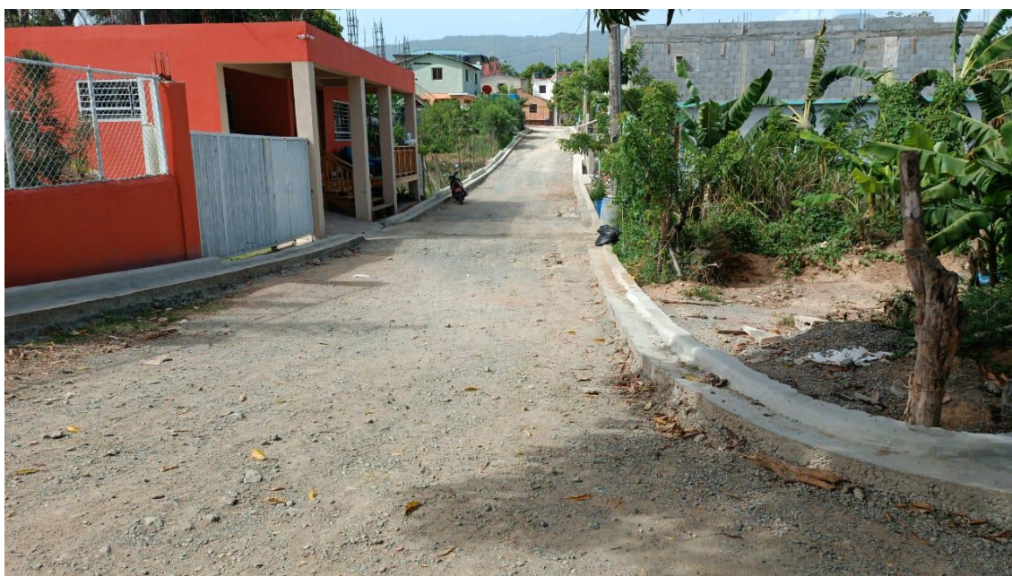
Construcción de contenes en el sector la Quebrada
