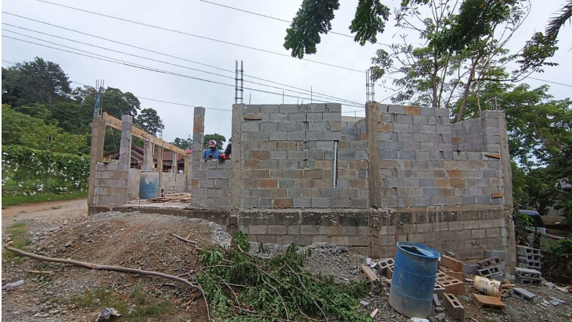
Salón Comunal en el sector Estancita (obra en ejecución).
