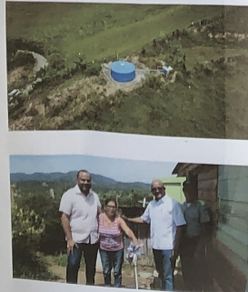
REMOZAMIENTO Y AMPLIACION DEL ACUEDUCTO EN YABCOA
