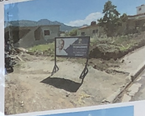
CONSTRUCCION DE ACERAS Y CONTENES DETRÁS DE LA OBRA SOCIAL SALESIANA
