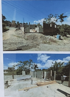
CONSTRUCCION SALON COMUNAL EN ESTANCITA
