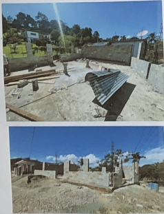
CONSTRUCCION SALON COMUNAL EN ESTANCITA
