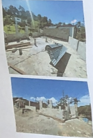
CONSTRUCCION SALON COMUNAL EN ESTANCITA
