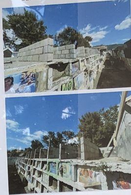
CONSTRUCCION DE NICHOS EN EL CEMENTERIO LA TRINCHERA
