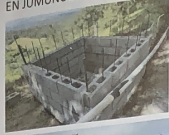
CONSTRUCCION DEL TANQUE PARA EL ABASTECIMIENTO DE AGUA POTABLE EN JUMUNUCO
