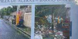
LIMPIEZA DE ACERAS - BARRIO DON BOSCO
