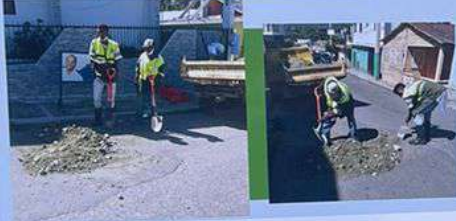
TRABAJOS EN LA C/ 16 DE AGOSTO
